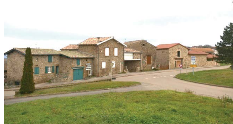
Exemple de forme bâtie de référence pour les logements groupés: alternance de façades parallèles et perpendiculaires, épannelage varié des toitures, alignements ou légers retraits par rapport à la voie (Gencenas – commune de Bessey)
