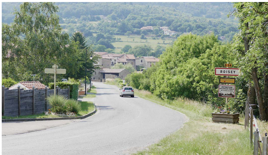
Le site en contrebas de la route marque l'entrée du bourg de Roisey (vue depuis la RD34 en provenance de Véranne)
