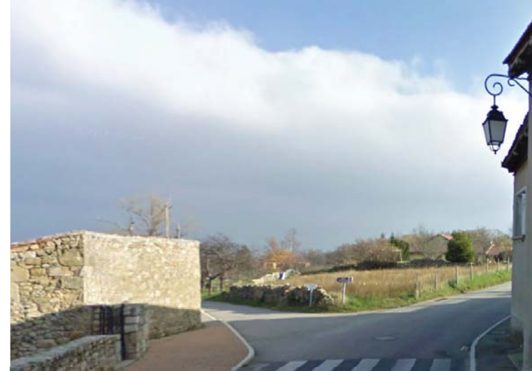
Vue frontale sur le tènement 2 en sortant du bourg en direction de Véranne par la RD34
